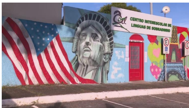
Figura 14 - Fachada frontal CIL de Sobradinho
