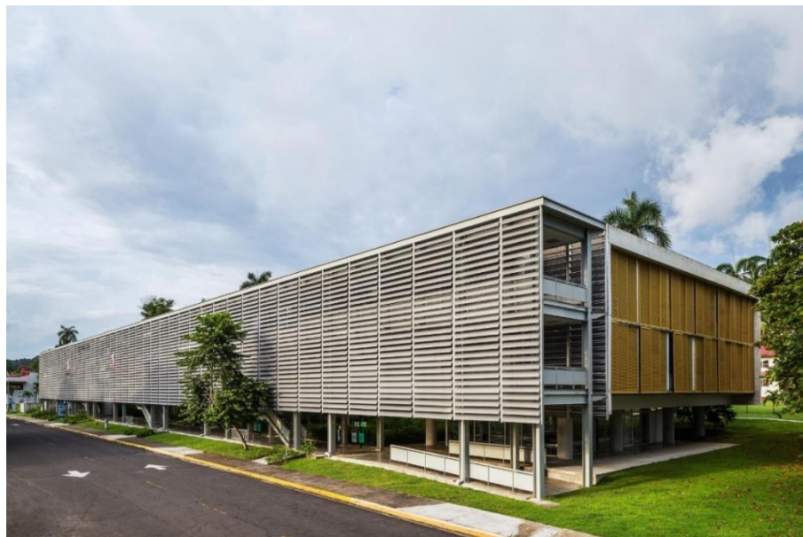
Figura 21 - Fachada voltada para rua local
