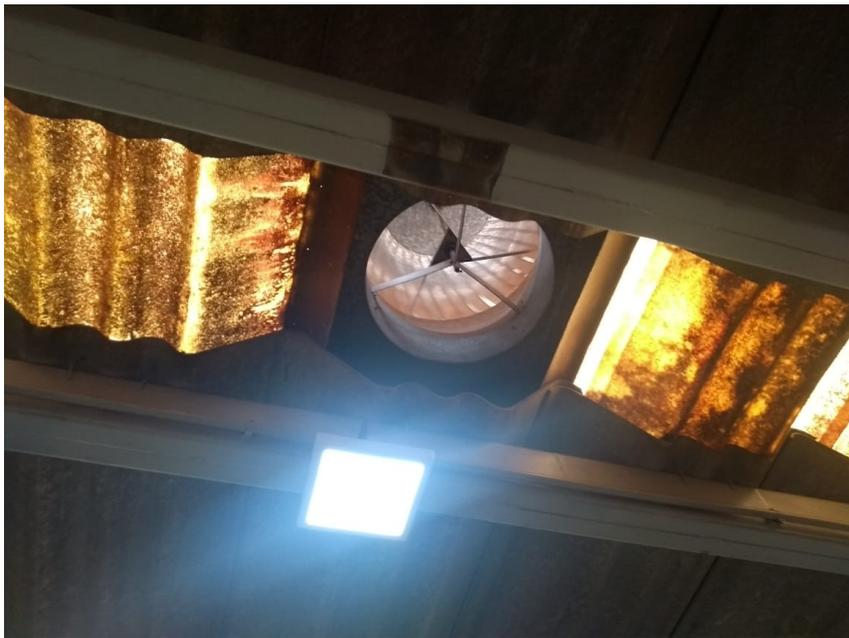
*Figura 6 - Exaustor no telhado. Fonte: Imagem do autor.*
