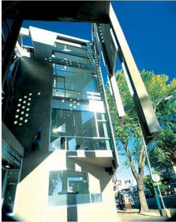
Figura 17. Fachada do Centro de Reabilitação Vicente López. Fonte: www.arcoweb.com.br
