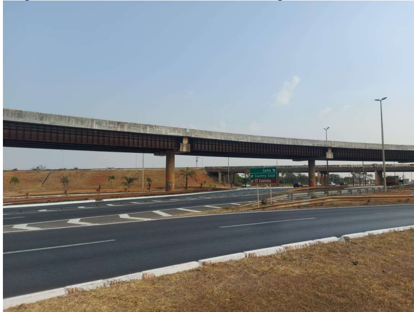
Figura 5 - Viaduto do BRT Sul da DF-065 próximo ao catetinho
