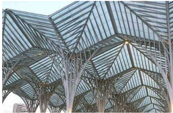
Figura 1 - Estrutura Metálica estação ferroviária.
