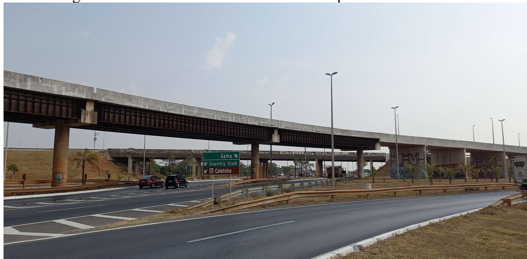
Figura 6 - Viaduto do BRT Sul da DF-065 próximo ao catetinho
