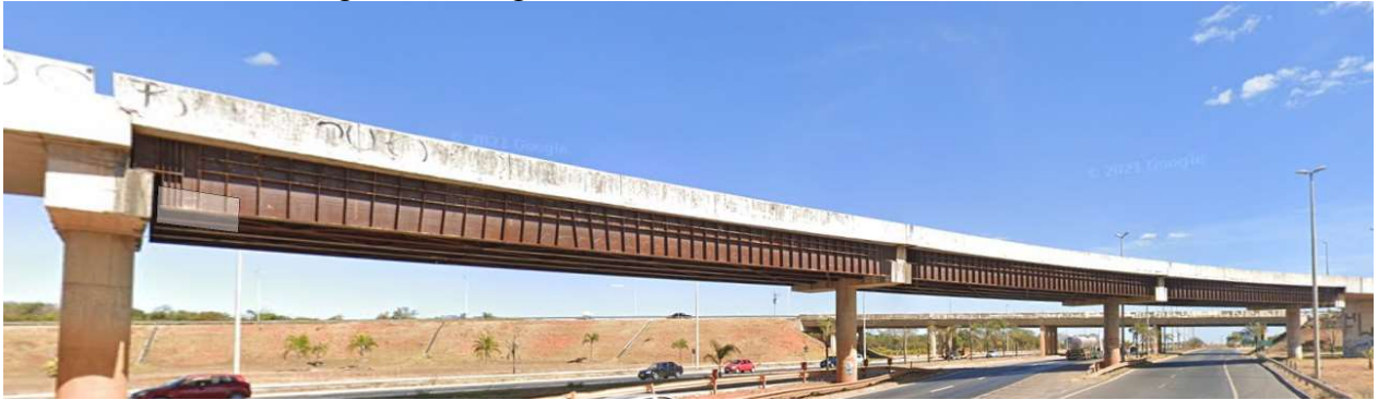
Figura 7 - Longarinas do viaduto do BRT do catetinho
