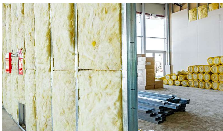
Figura 04 - Lã mineral entre o drywall
