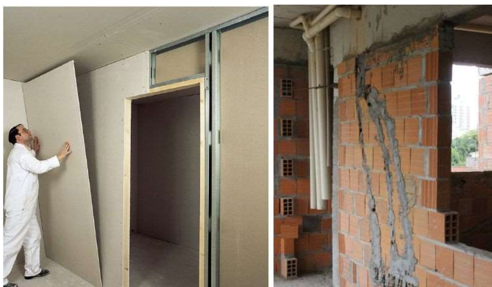
Figura 03 – Parede de alvenaria e parede de drywall
