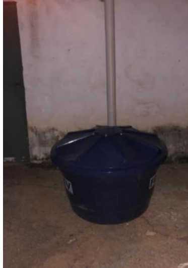
Figura 1 – Detalhe da instalação da caixa d'água para coleta de água pluvial.
