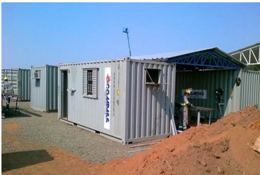
Figura 3 - Canteiro de Obra de Container
