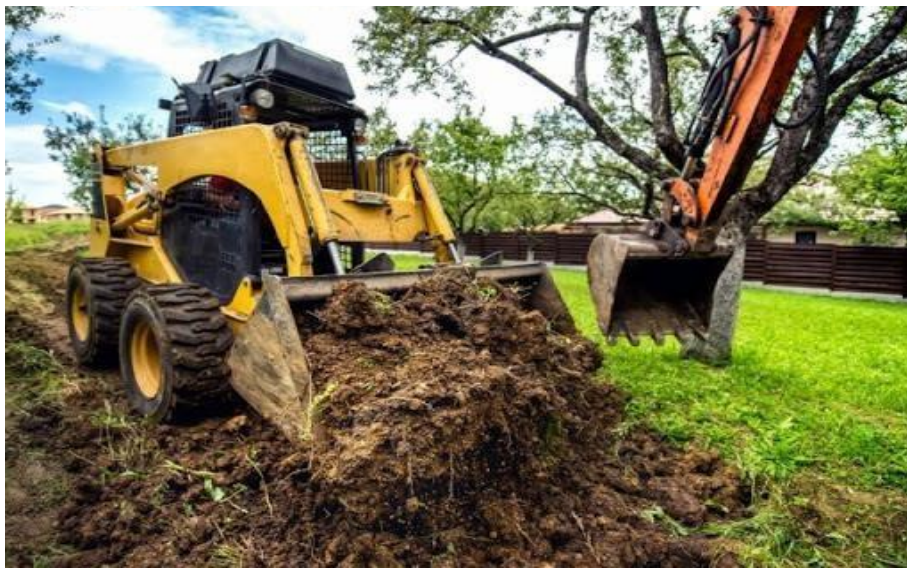
Figura 2 - Limpeza do Terreno
