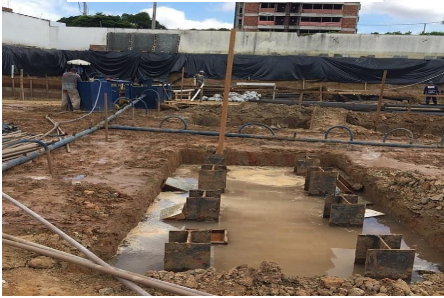
Figura 6 - Rebaixamento do Lençol
