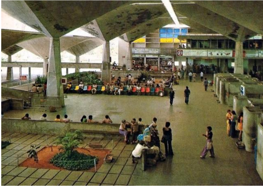
FIGURA 21: pilar e cobertura
