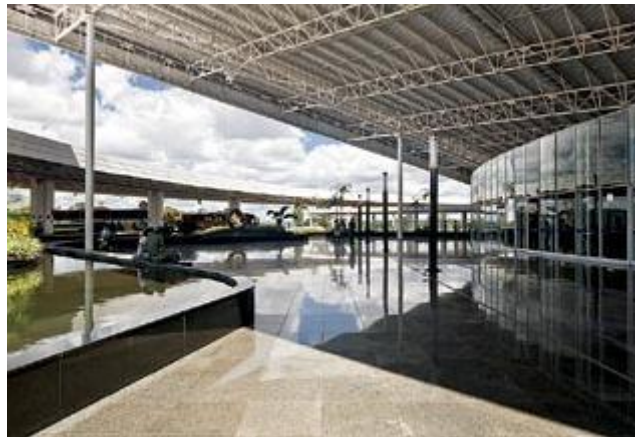
FIGURA 36: Parede curva. Ao longo da parede curva, esquadrias que podem ser abertas favorecem a ventilação natural dos espaços internos.
