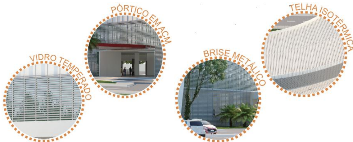
FIGURA 69: Detalhes da fachada e cobertura
