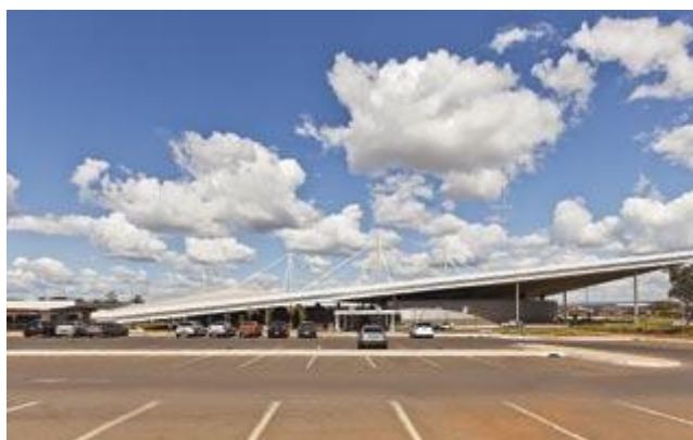
FIGURA 30: Vista lateral do terminal, a construção tem estrutura de concreto e vedação em blocos de concreto vazado. Os acabamentos empregam brises de chapas perfuradas e painéis.
