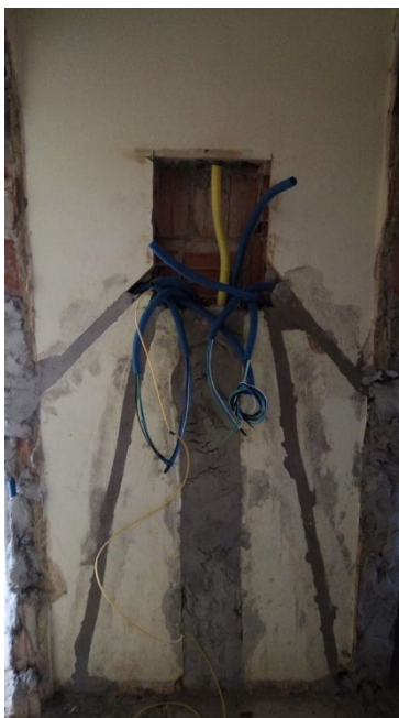
Figura 11: Rastro fechado para a passagem de tubulação elétrica
