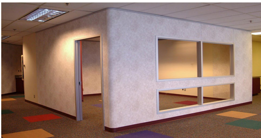
Figura 9: Parede de Drywall finalizada
