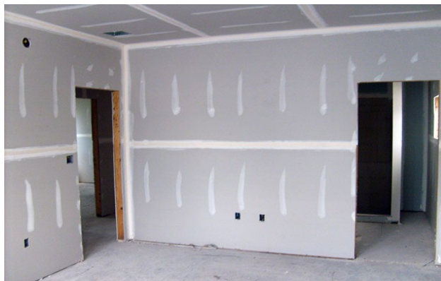
Figura 6 Parede de Drywall em Fase de Acabamento
