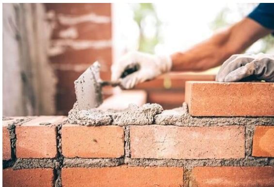
Figura 4 Parede de alvenaria
