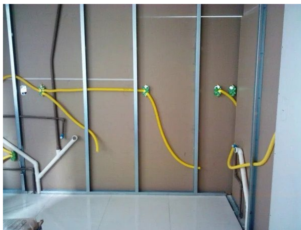
Figura 3 Instalação elétrica em parede de Drywall
