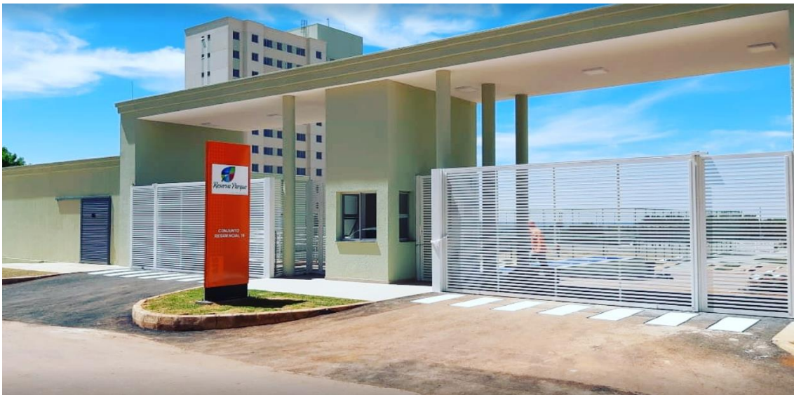
Figura 4 - Entrada do condomínio
