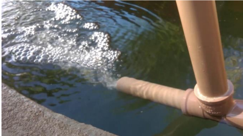
Figura 6 - Venturi responsável pela oxigenação da água
