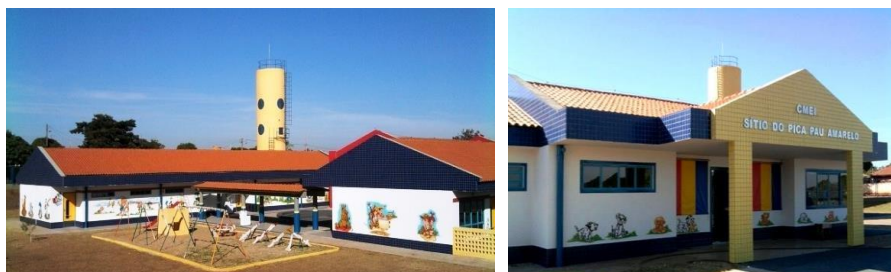
Figura 5 - Unidade tipo b construída.
