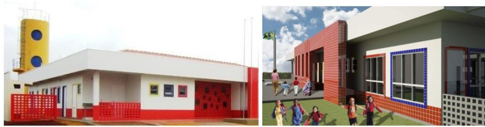
Figura 7 - Unidade tipo C construída
