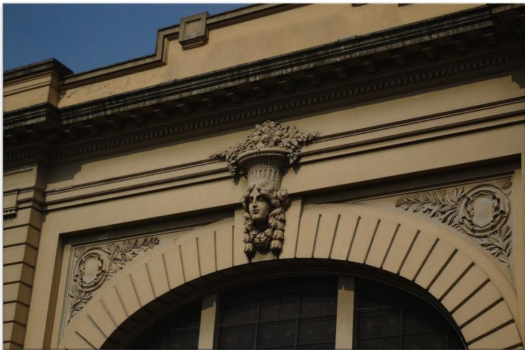
Figura 23- Vista exterior – Arco da Deusa Ceres
