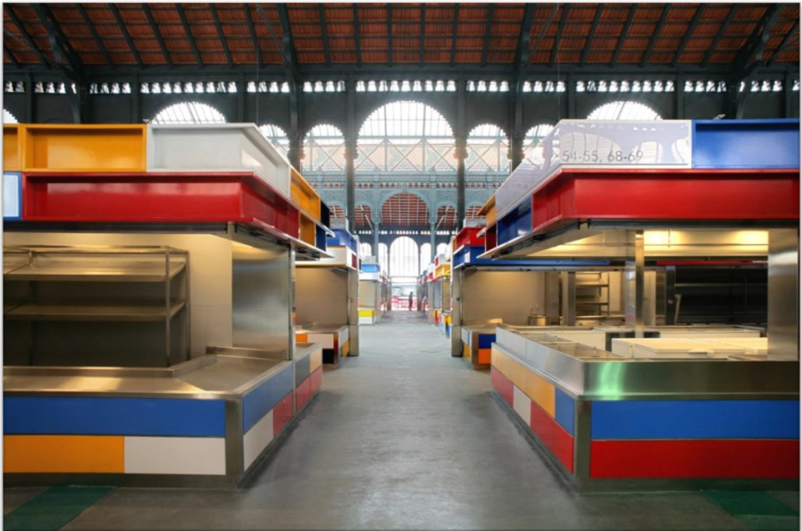
Figura 39 – Vista interna - boxes
