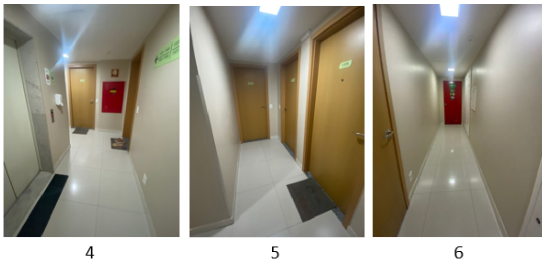
Figura 40 - Hall pavimento tipo gamagiore
