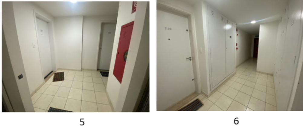
Figura 24 - Hall dos pavimentos tipo
