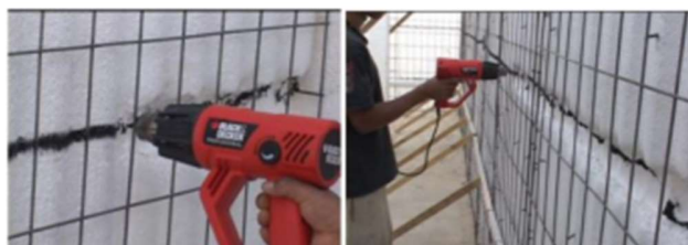
Figura 1 - Abertura para instalações com soprador térmico
