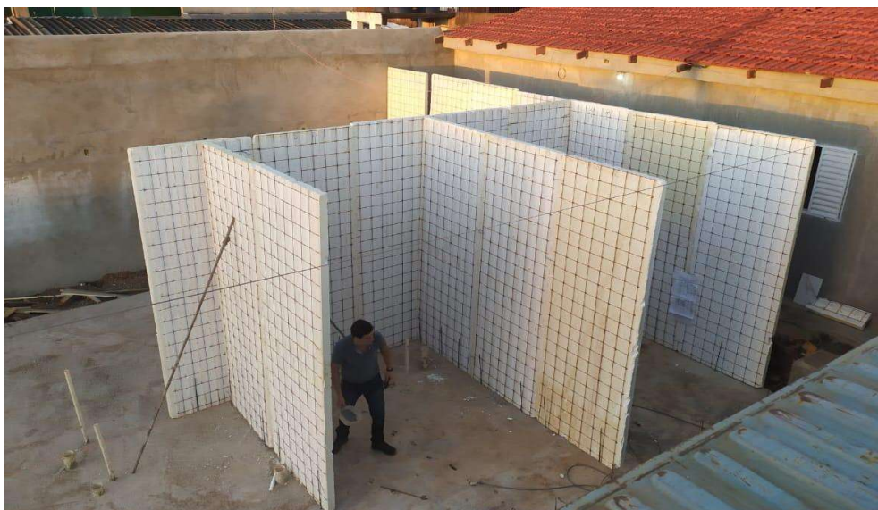
Figura 6 - Montagem dos Painéis
