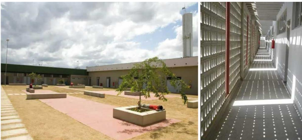
Figura 19-- Área Externa e Corredor da Cella
