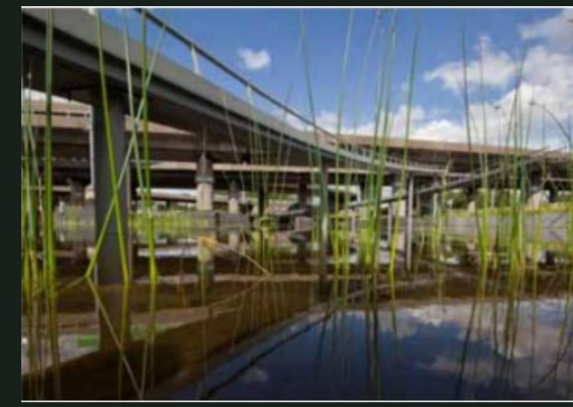
Armazenamento temporário de água sob o trevo da autoestrada Kleinpolderplein
