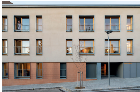
Figura 22 - Fachada Habitação Coletiva
