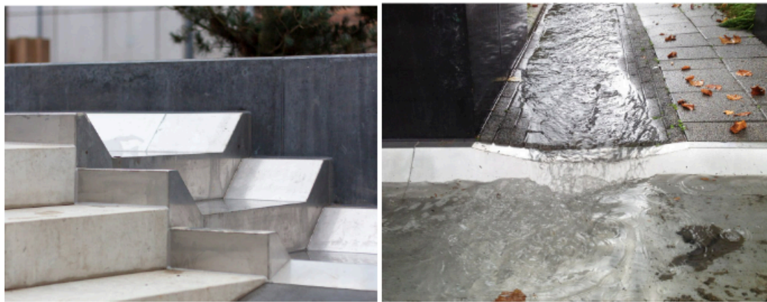
Figura 25 - Calhas inoxidável que percorre ao redor da praça
