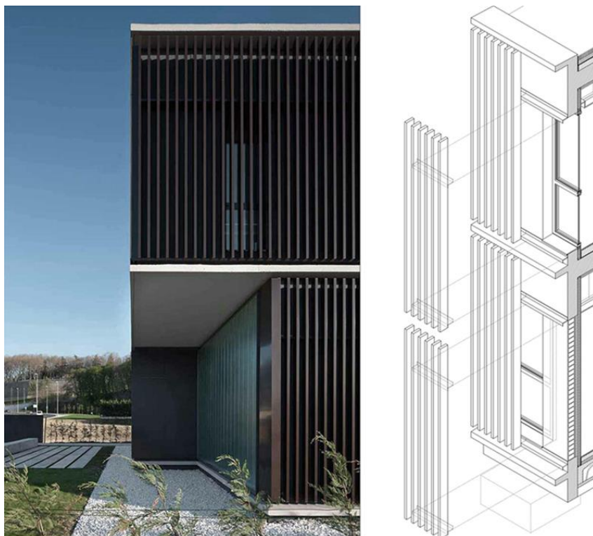
Figura 10: Fachada com brises
