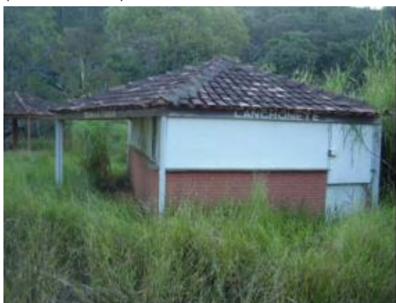
FIGURA 11 Estruturas do parque (Fonte:IBRAM)
