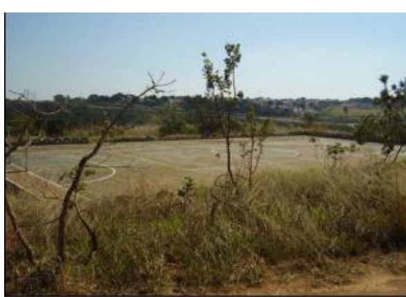
FIGURA 18 Estruturas do parque (Fonte:IBRAM)
