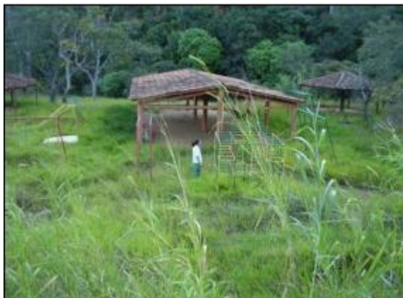
FIGURA 9 Estruturas do parque (Fonte:IBRAM)
