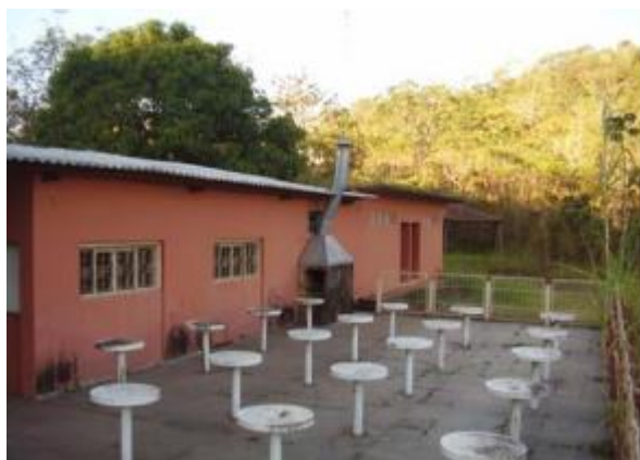
FIGURA 10 Estruturas do parque (Fonte:IBRAM)
