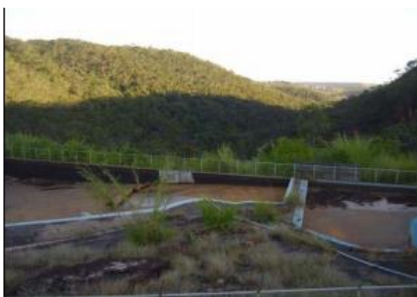
FIGURA 17 Estruturas do parque (Fonte:IBRAM)
