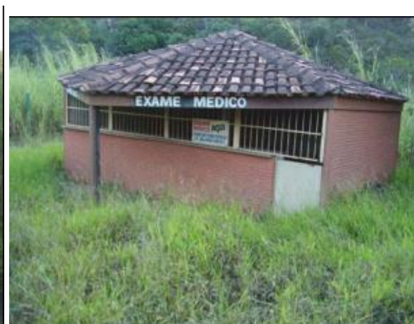
FIGURA 14 Estruturas do parque (Fonte:IBRAM)
