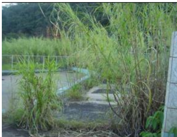
FIGURA 16 Estruturas do parque (Fonte:IBRAM)
