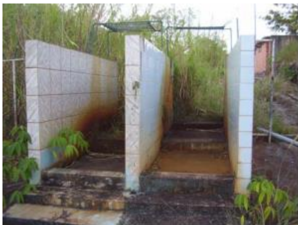
FIGURA 15 Estruturas do parque (Fonte:IBRAM)
