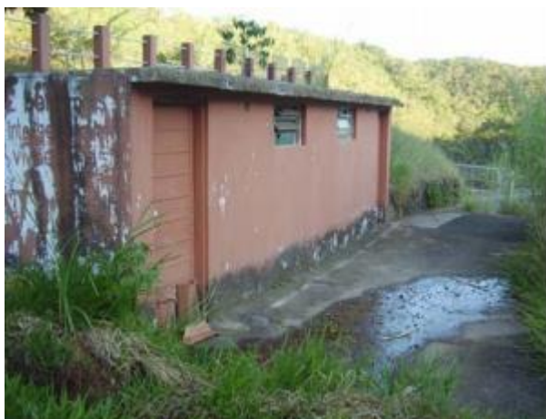
FIGURA 13 Estruturas do parque (Fonte:IBRAM)
