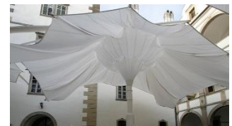
Figura 72 – Cobertura TENARA SEFAR
