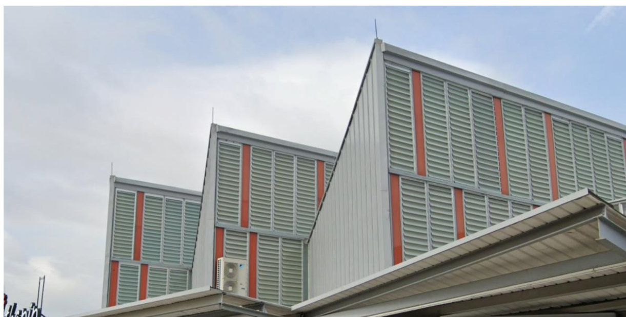
Figura 23 – Detalhe ventilação, Mercado da Vila. Fonte: Google Maps
