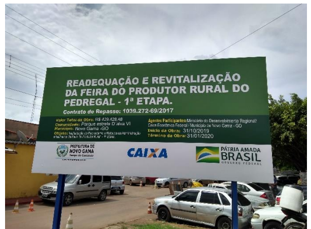
Figura 46 - Placa com dados sobre reforma da feira. Fonte: Imagem do autor
