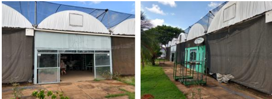
Figura 48 - Estrutura da edificação. Ferro e lona. Fonte: Imagem do autor.
