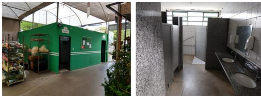
Figura 51 - Sanitários. Fonte: Imagem do autor.
