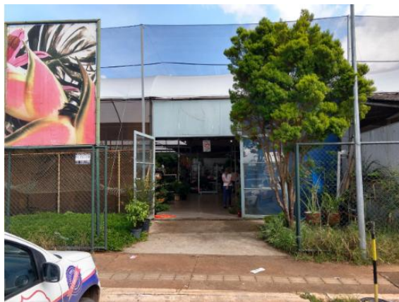
Figura 45 - Fachada Lateral leste. Entrada para o mercado. Fonte: Imagem do autor.
