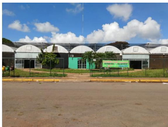
Figura 46 - Fachada norte. Fachada principal do edifício. Fonte: Imagem do autor.
