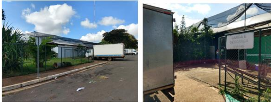
Figura 47 - Lateral oeste. Acesso p/ carga e descarga. Fonte: Imagem do autor.
