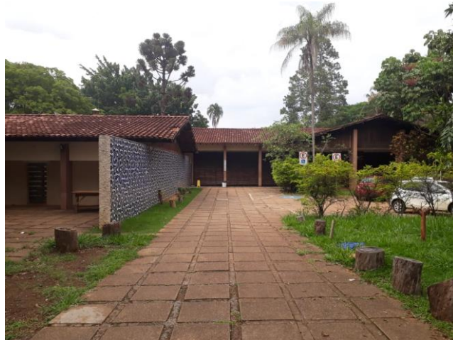
Figura 13 - Imagem do bloco de recepção e acolhimento do CAPS II
