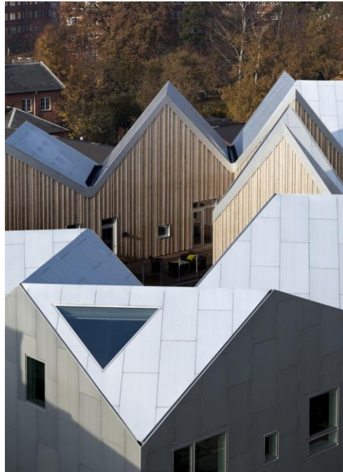
Figura 12 - Perspectiva do Centro de Saúde evidenciando a cobertura
