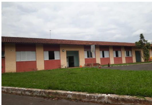
Figura 14 - Imagem do bloco de recepção e acolhimento do CAPS II
