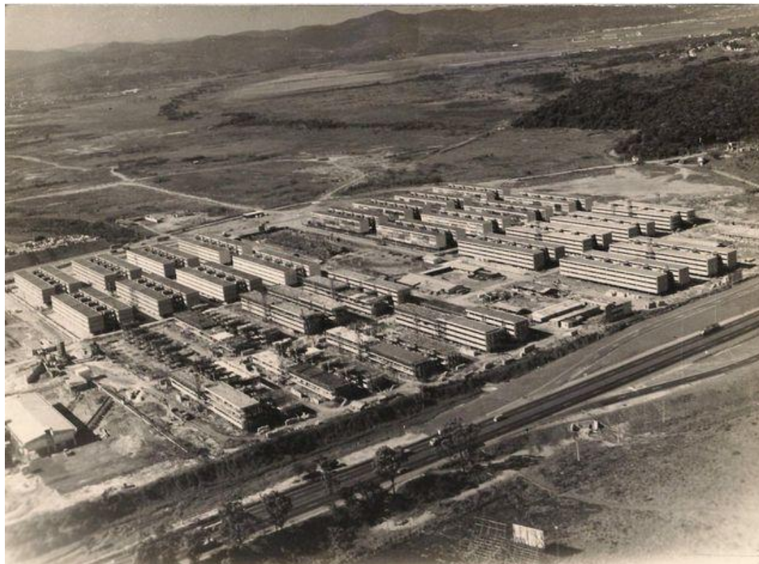
Figura 1 - Conjunto Habitacional Zezinho Magalhães em construção, em 1975
